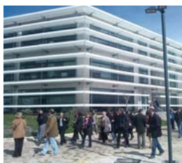
Edificio OTE/Cosmote Paiania (GR)
